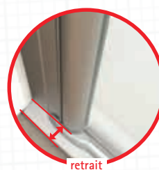
Le profilé mural est installé en retrait du bord du receveur.
