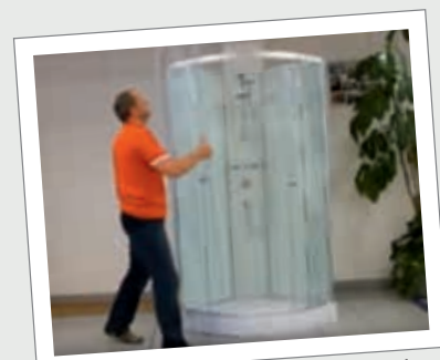
et pour finir, je monte les parois.
